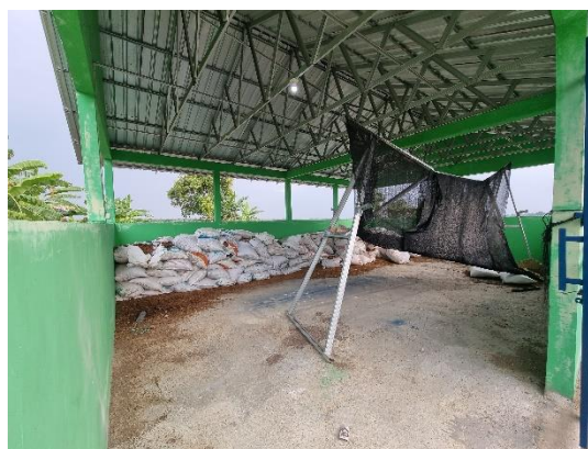
Tampak Dalam Bangunan TPS 3R
