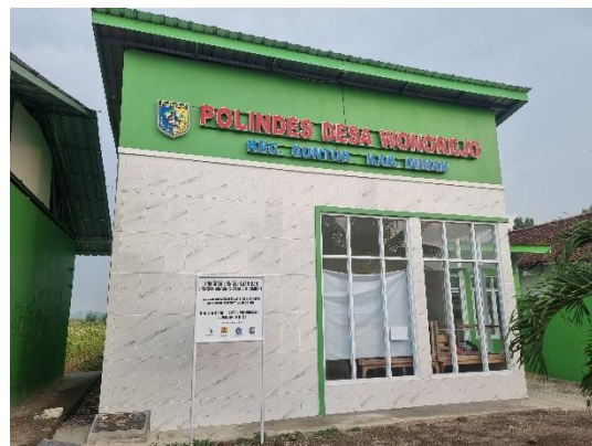
Bangunan Polindes di Samping Bangunan TPS 3R
