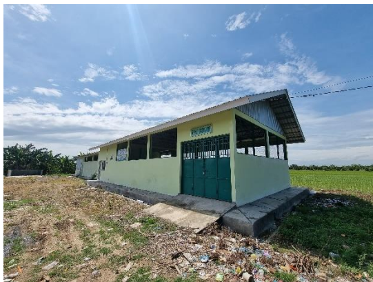
Bangunan TPS 3R
