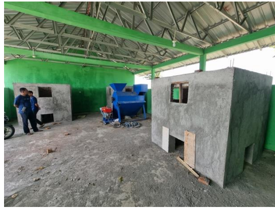
Tampak dalam Bangunan TPS 3R
