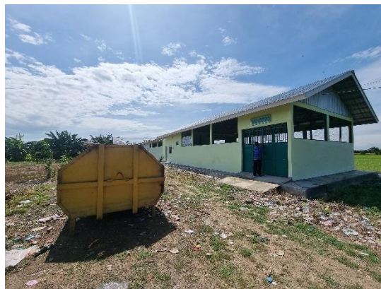
Area Kontainer dan Bangunan TPS 3R
