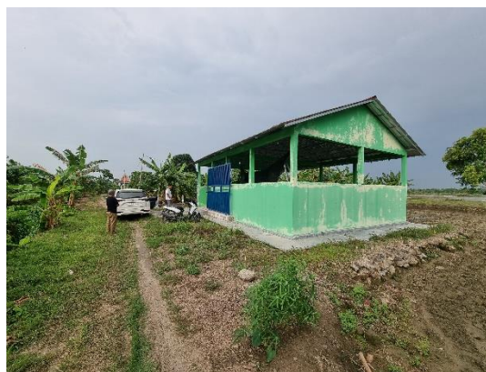
Akses Jalan di depan TPS 3R
