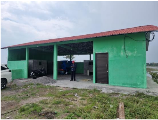
Bangunan TPS 3R
